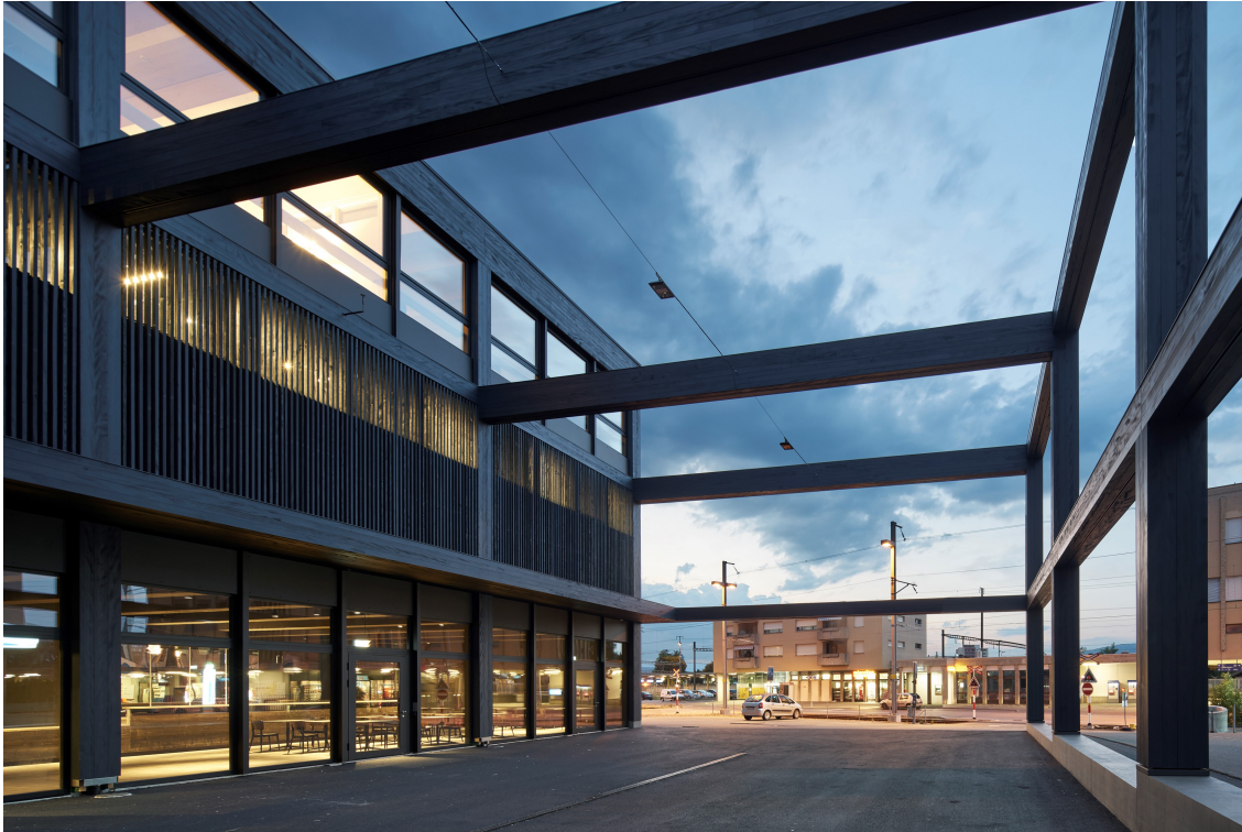
Dunkler Holzbau: Je nach Lichteinfall schimmert die blaue Fassade heller oder dunkler. Foto: Ralph Feiner
