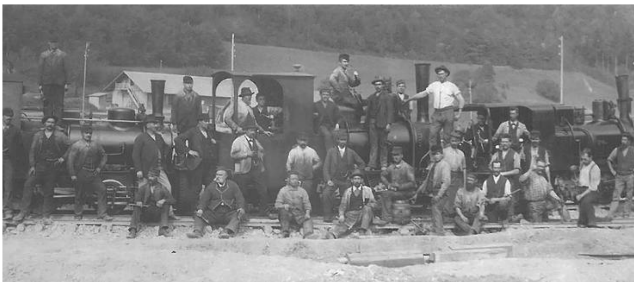
Ein Bautrupps des Nationalbahn-Streckenabschnittes von Suhr nach Zofingen posiert stolz vor drei Bauloks.
