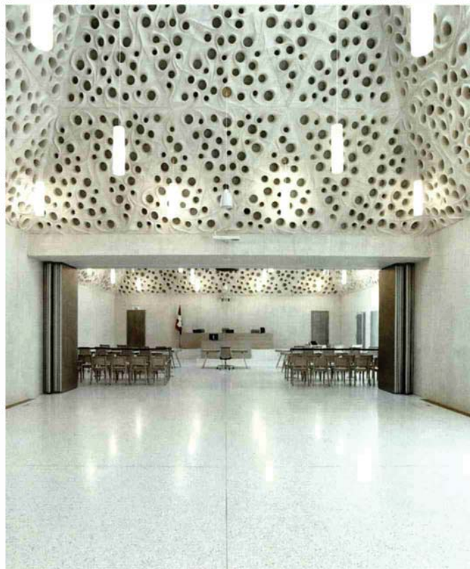
Bundesstrafgericht Bellinzona. Der Weissbeton wirkt einerseits als thermisch aktiviertes Bauteil und andererseits als schalldämmendes Element.
