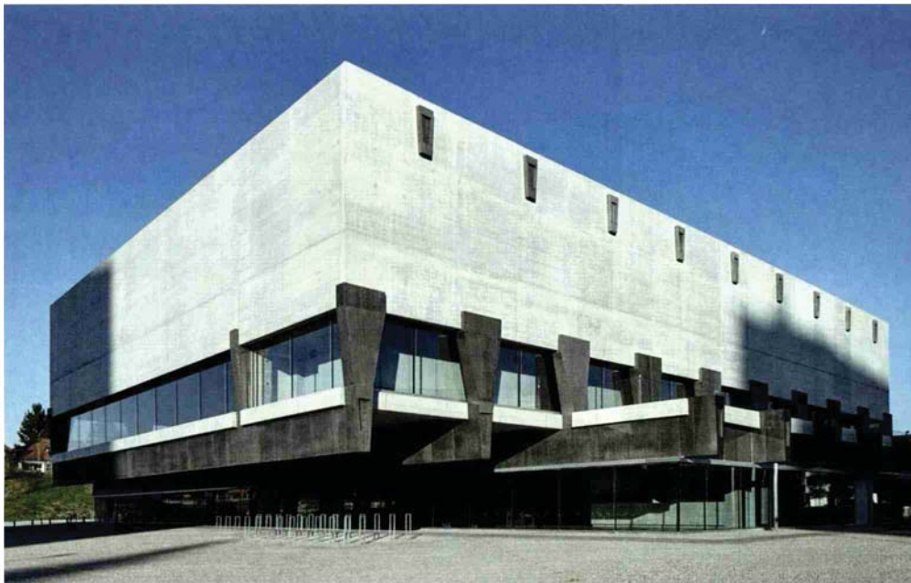
Sporthallen Weissenstein, Bern. Unterzüge aus vorgespanntem Beton ermöglichen den Bau freier Hallen ohne störende Stützen.
